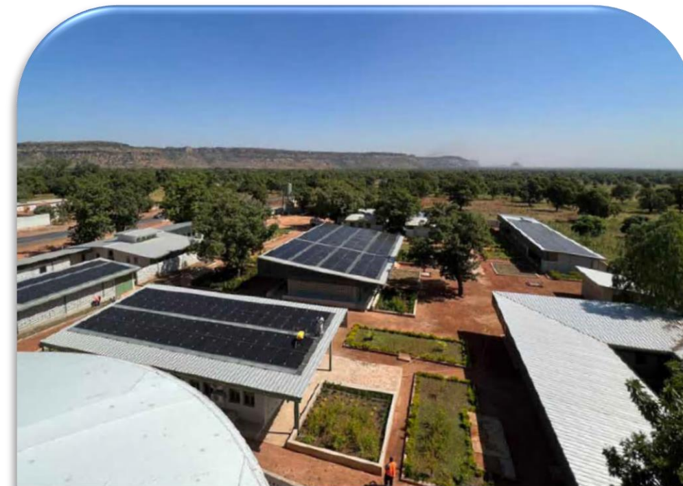
CENTRALE PV/DIESEL HYBRIDE DE 136,5kWc / MALI (POUR EXPLOITATION D'UN CENTRE DE FORMATION)
